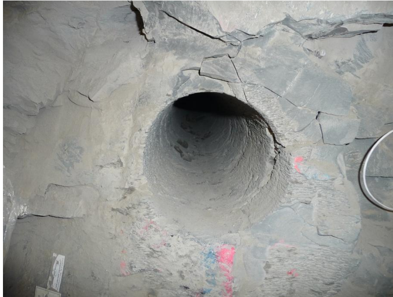
Figure 4-1. Breakout d'un forage effectué à partir d'une galerie du laboratoire de Bure (Photographie d'Arjun Makhijani, 18 août, 2010. P1020429)
