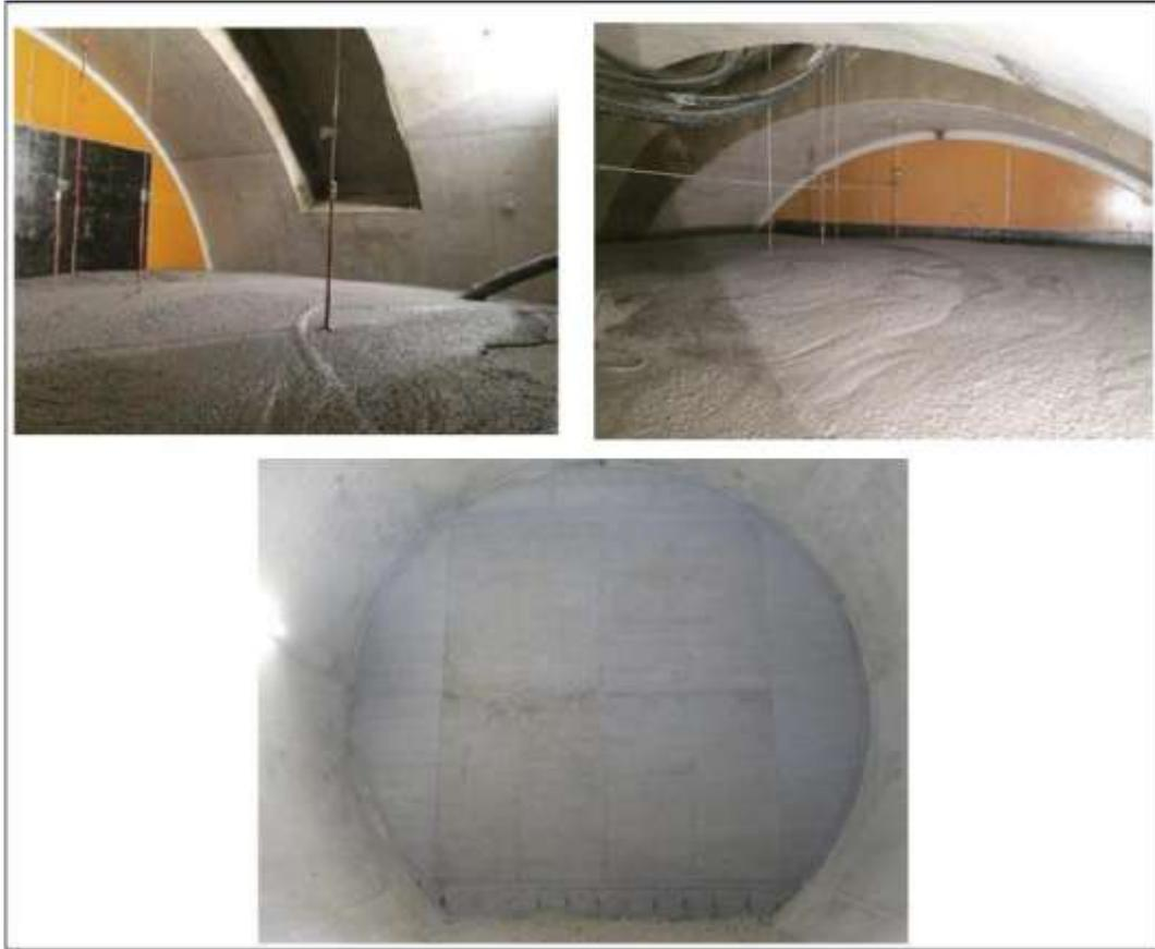
Figure 17 : FSS (*Full Scale Seal*) : coulage d'un massif d'appui en béton bas pH autoplaçant de 250 m<sup>3</sup> (Andra [2], 2014)
