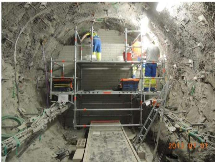
Figure 12 : NSC : mise en place du noyau de briques de bentonite compactées (Andra [2], 2013)
