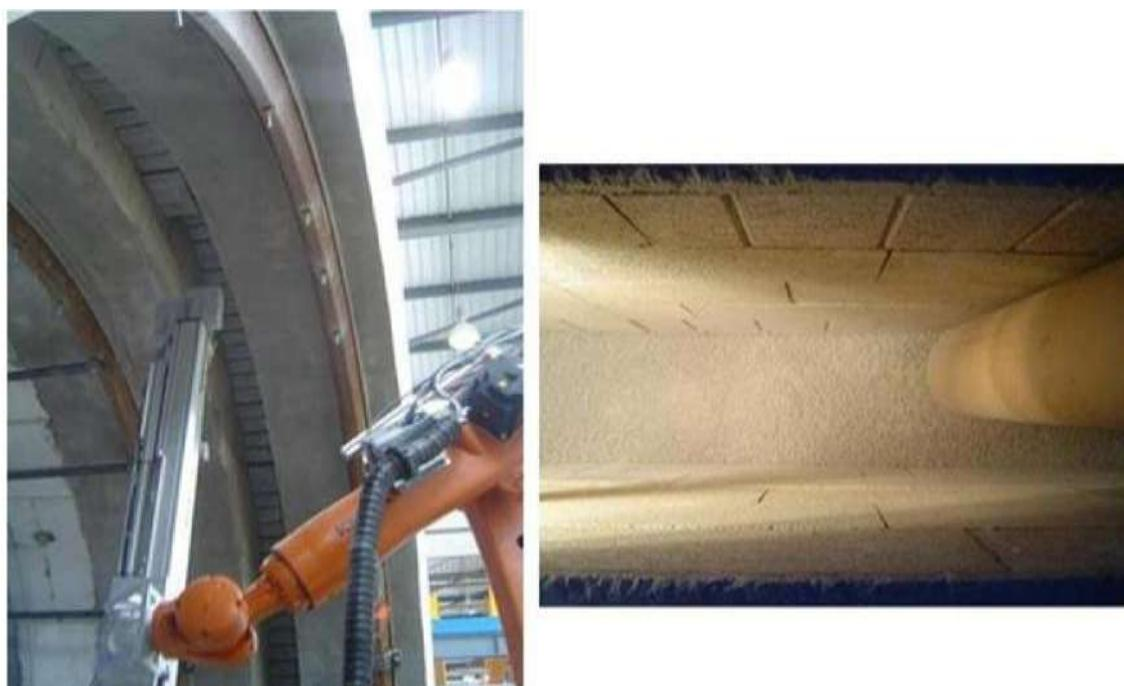
Mise en place robotisée de briques compactées en partie haute - Mise en place de pellets/poudre en partie basse
