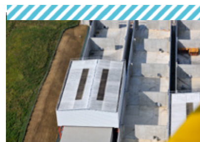
Centre de stockage de l'aube - alvéoles en cours de remplissage
