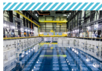
Les piscines des usines de La Hague permettent d'entreposer les combustibles en attente de traitement, en vue de valoriser les matières radioactives qu'ils contiennent.
