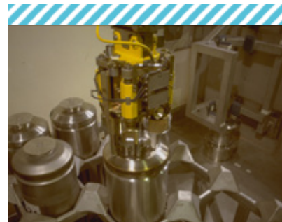
Exemple de colis de déchets MA-VL (moyenne activité à vie longue) compactés : déchets technologiques, coques et embouts
