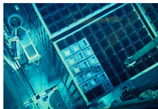
Piscine de refroidissement (EDF Belleville)
